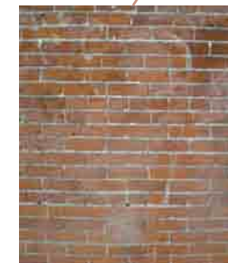
l) brick structure
